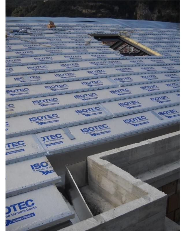
Isotec con funzione portante su struttura discontinua in metallo.
